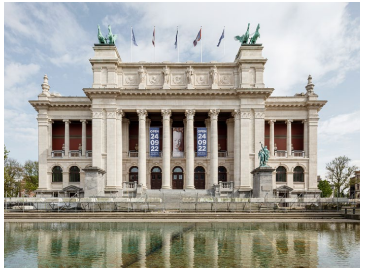
KMSKA, Fassadenansicht 2022 © Karin Borghouts
